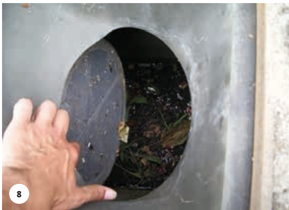
6. Esempio di applicazione di una zanzariera su un tombino come efficace barriera fisica contro le zanzare (da: www.ecologik.it ); 7. Applicazione di una zanzariera basculante su un tombino in un cortile privato (da: https://zanzarastop.it ); 8. Principio di funzionamento di una zanzariera basculante applicata ad un tombino per il deflusso delle acque (da: www.ecologik.it ); 9. Utilizzo di compresse per il controllo dei focolai larvali in tombini e caditoie. Si tratta di batteri oppure di inibitori della crescita, entrambi ad azione larvicida. Da usare SOLO in piccole raccolte di acqua isolate (da: www.zerozanzare.it )
