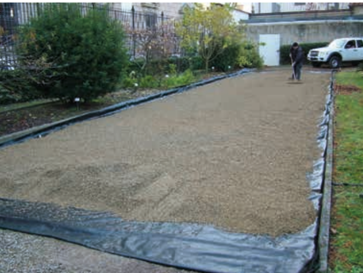
3. A sinistra, posa in opera di telo pacciamante; a destra opera finita (Foto Luciano Di Fazio)
